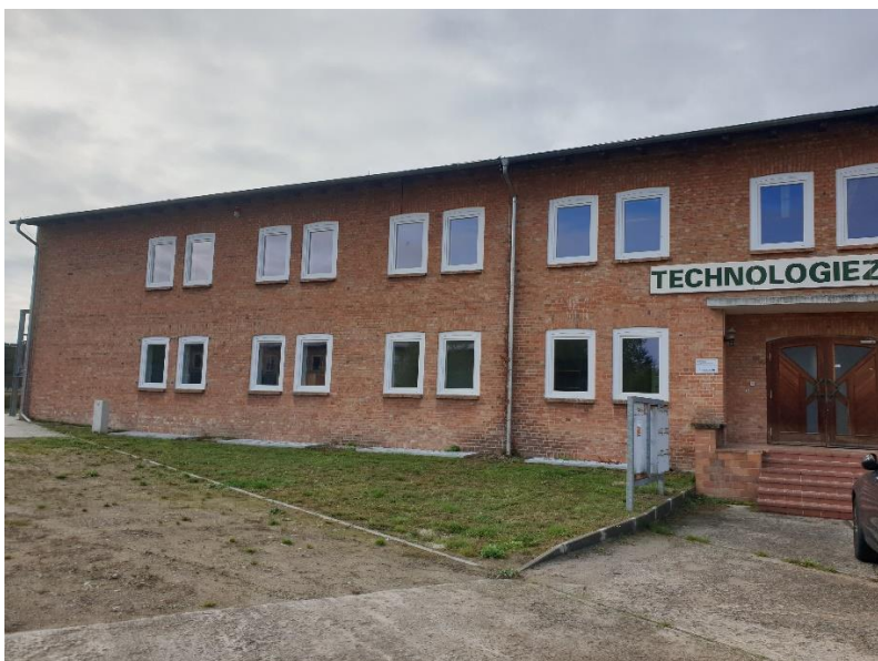
Bild 7) Schulungsgebäude am Brandcontainer am Standort in der Gemeinde Pinnow, Stadt Schwedt/Oder
