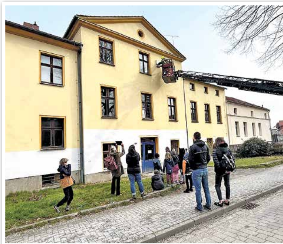
Die Fassadenquartiere für gebäudebewohnende Fledermausarten werden angebracht
