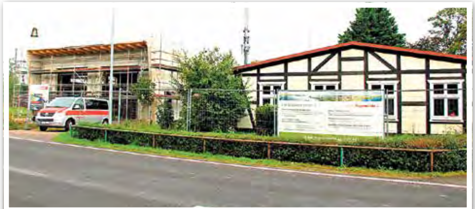
Direkt neben dem Dorfgemeinschaftshaus in Wilmersdorf entsteht das neue Feuerwehrgebäude mit Verbindung zwischen beiden Gebäuden.
