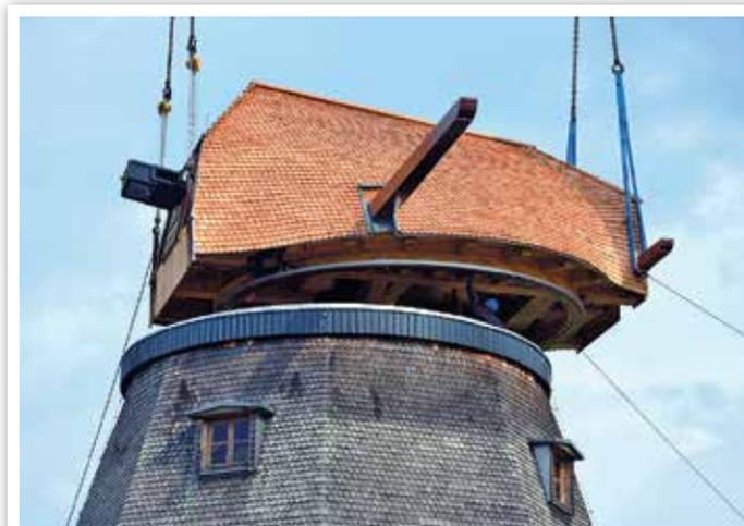
Die auf der Erde vorgefertigte und 17 Tonnen schwere Kappe der Mühle
