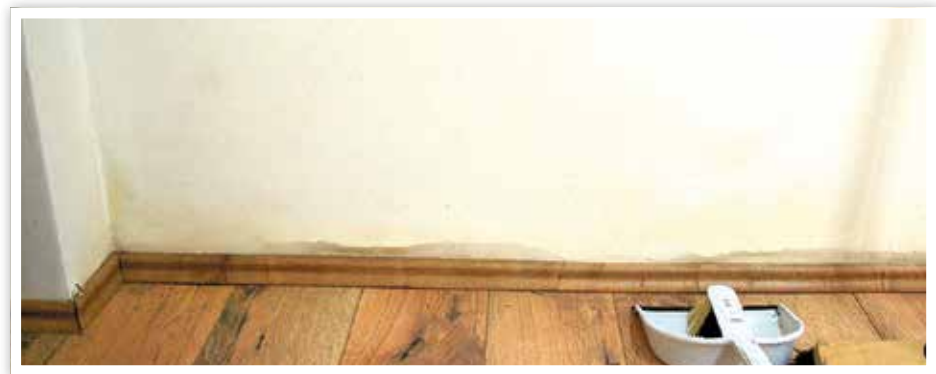
Der hohe Feuchtigkeitsgehalt der Luft führte zur Lockerung des Putzes im Bürozimmer.
