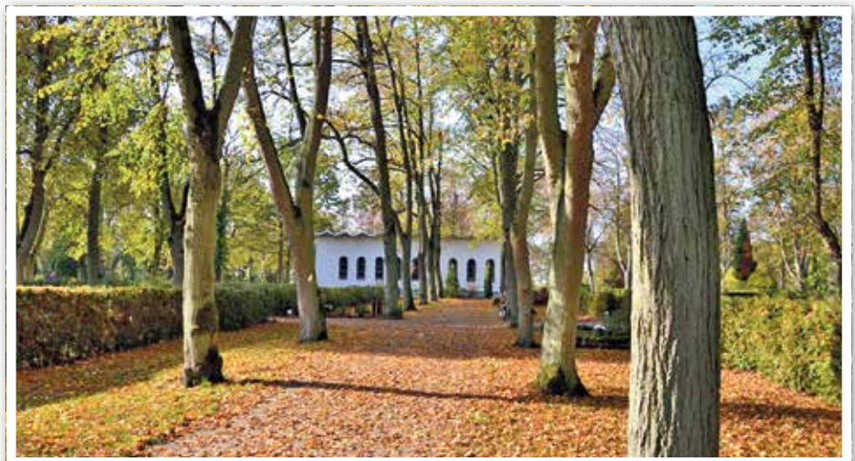
Das restaurierte Moschel-Mausoleum auf dem Stadtfriedhof Angermünde soll zukünftig wieder für Bestattungen genutzt werden.
