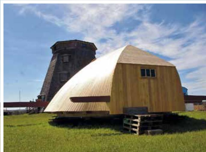
Die Mühlenkappe ist fast fertig, muss mit Schindeln verkleidet werden, bevor sie auf die Mühle aufgesetzt wird.
