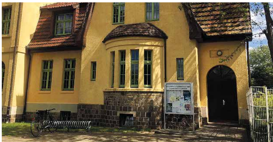
Regionalstelle Angermünde am Einstein-Gymnasium
