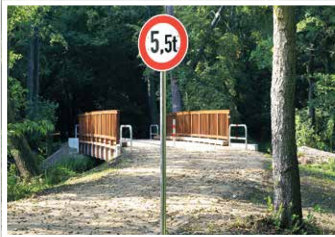
Die Sicht aus Richtung Angermünde auf die komplett fertige Brücke einschließlich Anfahrtsrampe, Durchfahrtsverbotschild für Lkws und andere schwere Fahrzeuge und Durchfahrtsperre.
