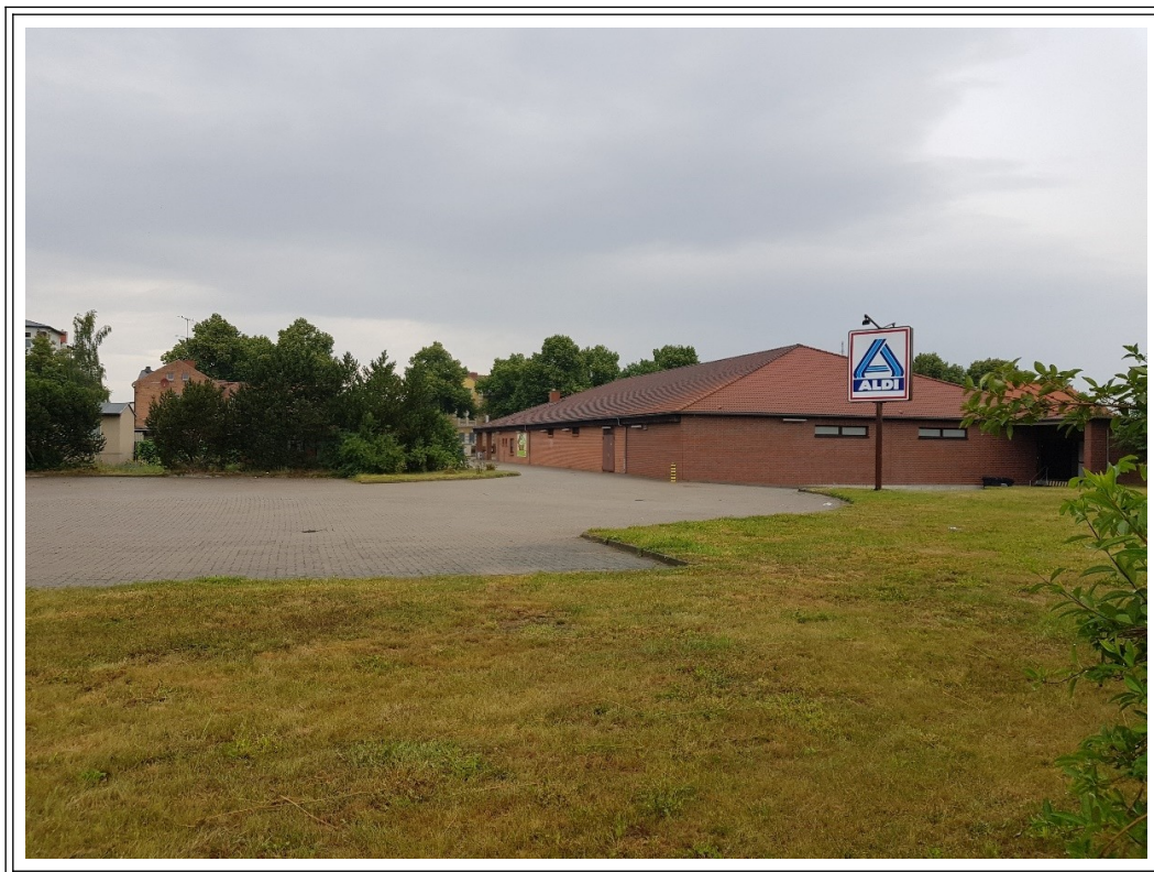
Abbildung 34: Plangebiet, Blick von Süden Richtung Schwedter Straße
