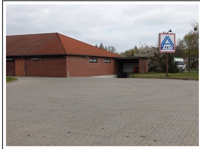
Abbildung 25: Großflächig versiegelter Parkplatz
